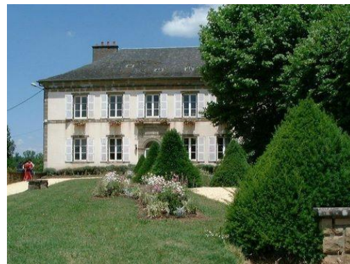
En 1999, construction d'un nouveau bâtiment d'enseignement pour les BTS.
